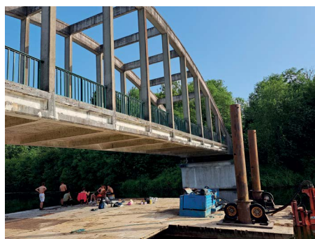
Barge installée sous le pont, permettant la réalisation des travaux sous le tablier.
